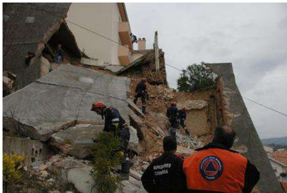
Figura 5.31 – Operações de estabilização de um deslizamento de vertente
