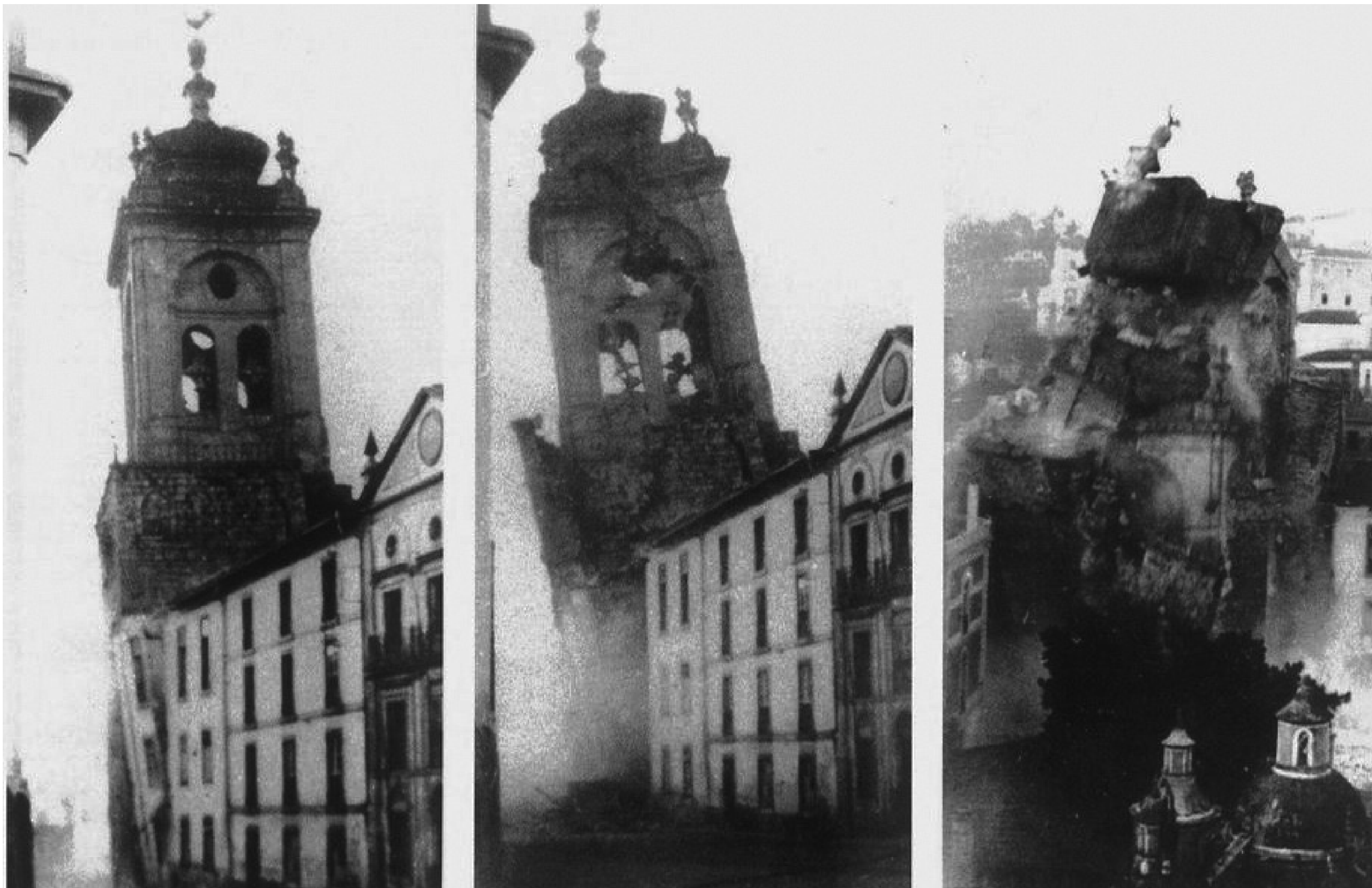
Demolição da Torre dos Sinos do Mosteiro de Santa Cruz e consequente destruição de parte da Enfermaria e Celeiro, 1935
