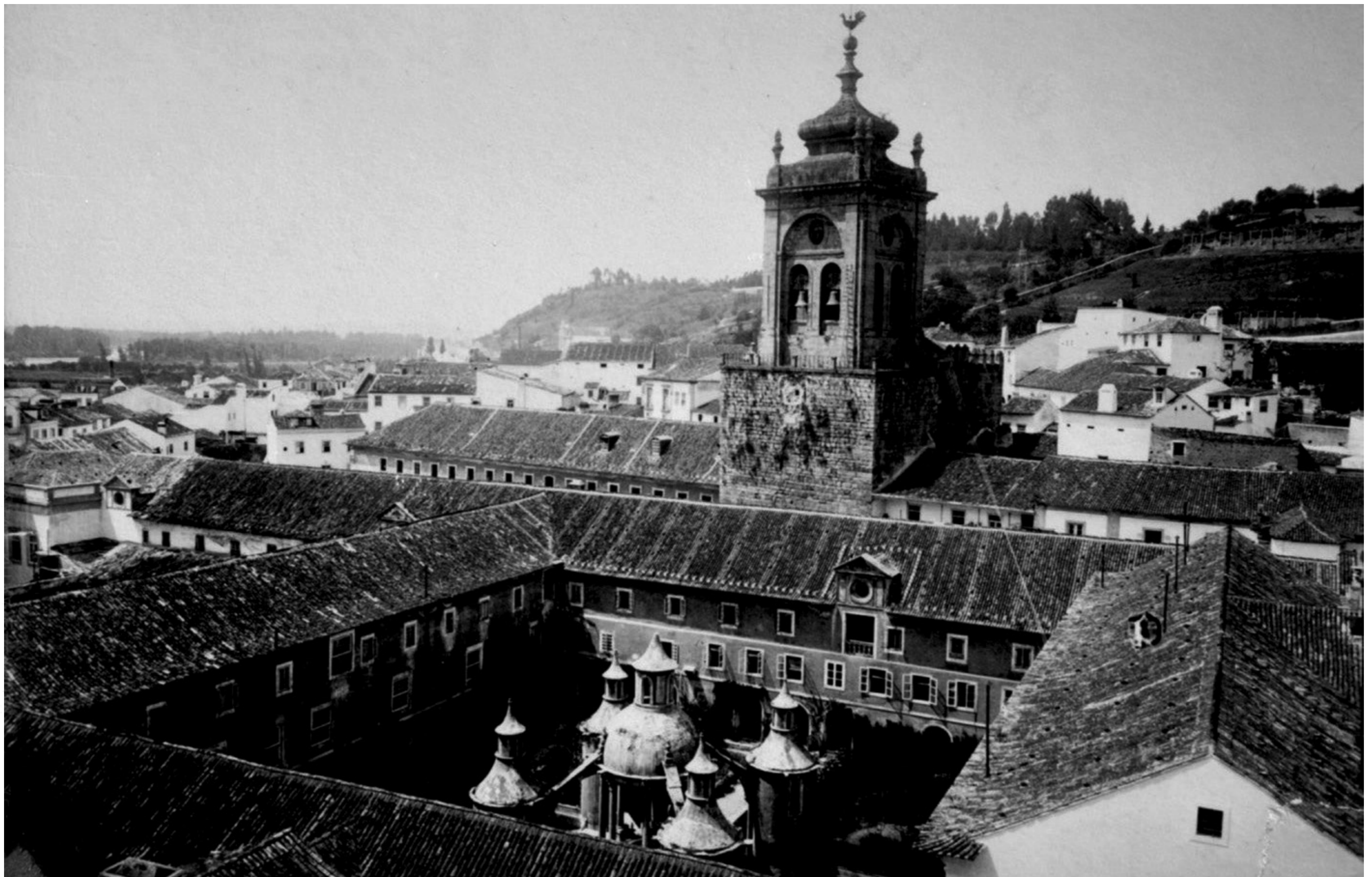
O Claustro da Manga, a Torre dos Sinos, o Celeiro e a Enfermaria do Mosteiro de Santa Cruz, c. 1880
