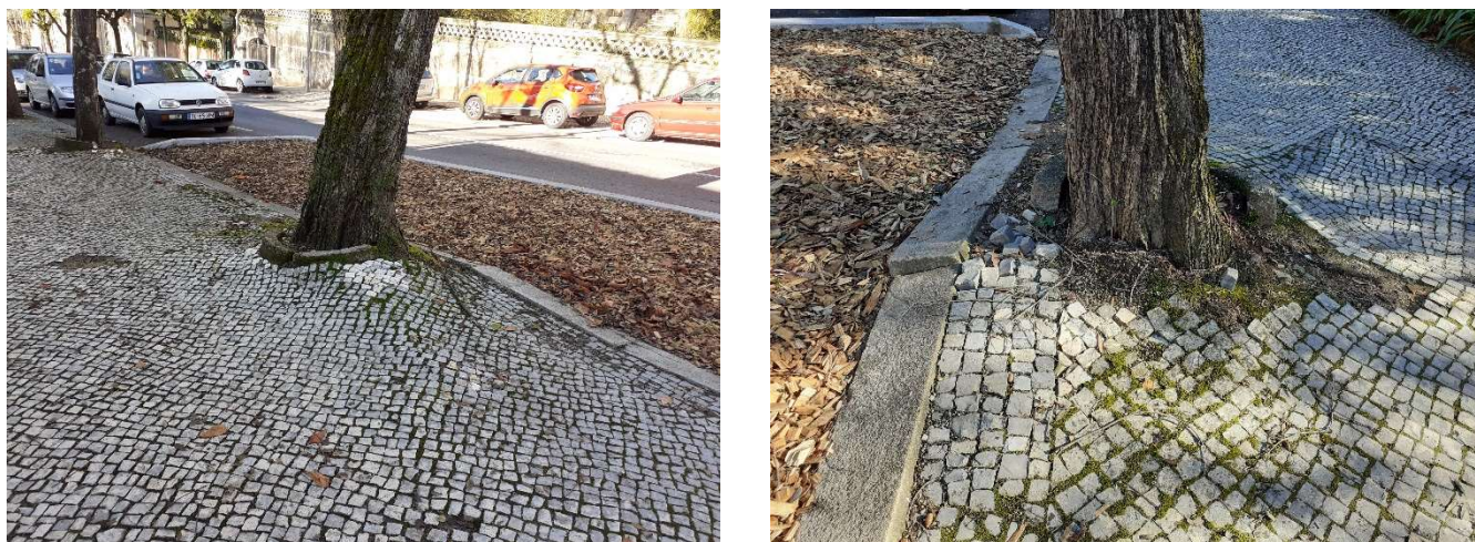
Figura 5 – Presença de ondulação e deformação do pavimento na ZISR.
