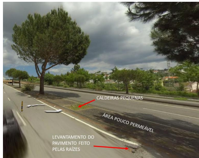
Figura 1. Pormenor do separador da Avenida Elísio de Moura onde se encontram implantados os pinheiros-mansos ( Pinus pinea ). Salienta-se a dimensão exígua das caldeiras, a forte impermeabilidade do asfalto e do separador, e levantamento do asfalto provocado pela raiz de pinheiro. Fotografia do Google Earth de março de 2022.
