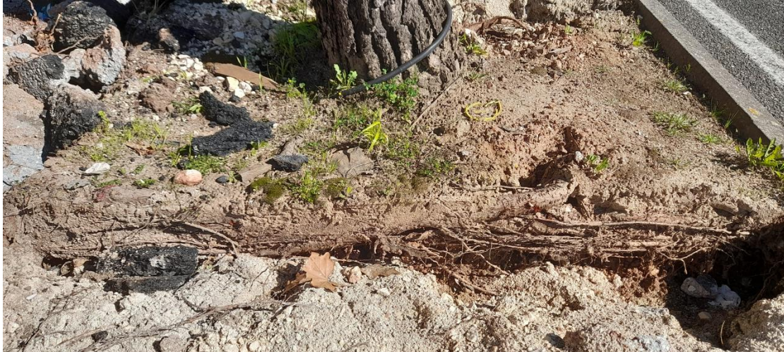
Figura 8. Detalhe do crescimento horizontal de raízes primárias (mais finas) e secundárias (mais grossa) ao longo do lancil.
