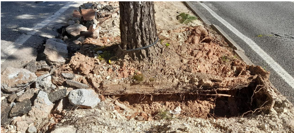
Figura 4. Crescimento confinado das raízes de pinheiro-manso restringido pela dimensão da caldeira. De salientar o levantamento do pavimento do lado esquerdo e direito da árvore.
